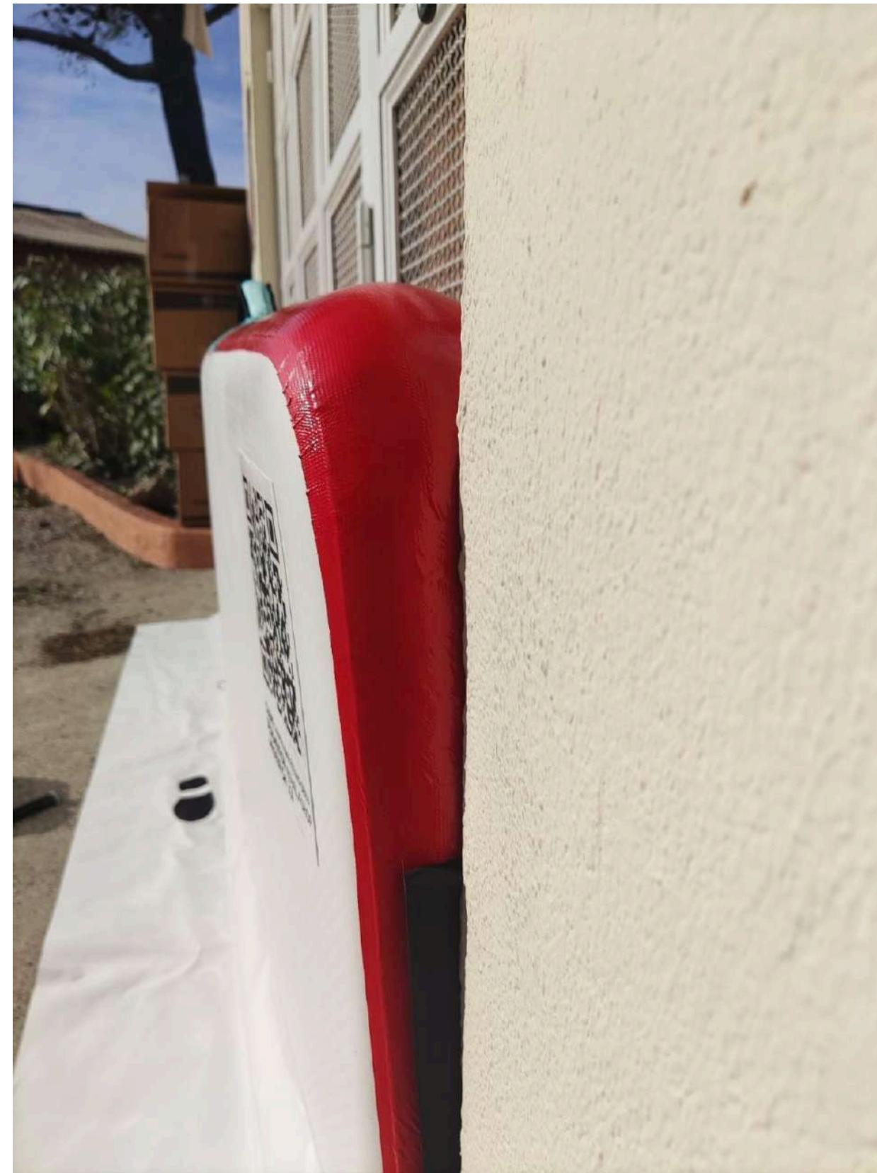
La pression exercée par la poussée du FlowStop sur le mur empêche le dispositif de sortir de l'encadrement, et le joint par écrasement assure l'étanchéité
