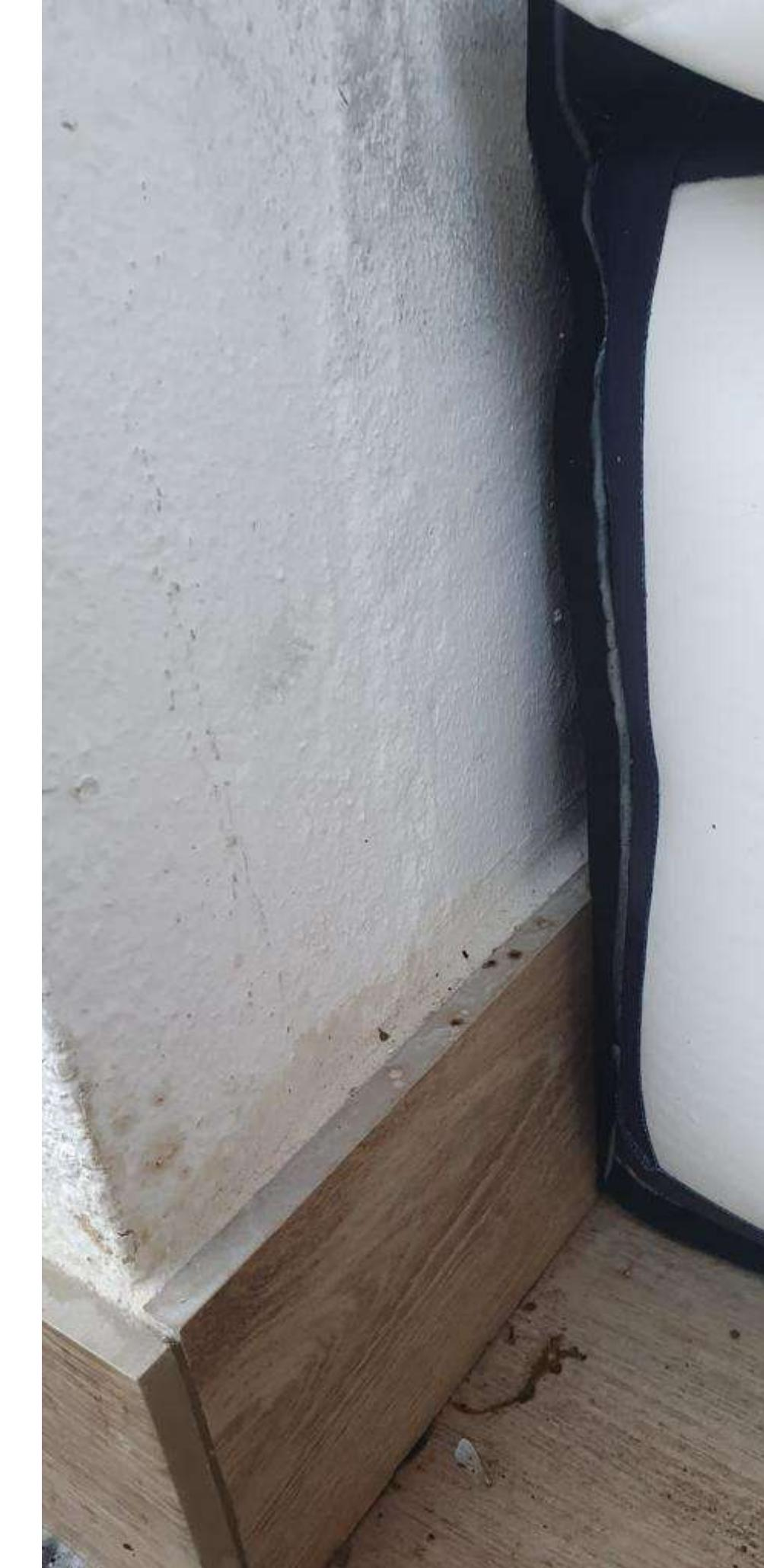
Les plinthes peuvent constituer un obstacle à l'étanchéité du dispositif, au-delà de 7mm le joint ne peut plus assurer l'étanchéité, il est donc fortement conseillé soit de prévoir, un matériel permettant de combler ce déficit, soit de mettre une bande de joint supplémentaire.
